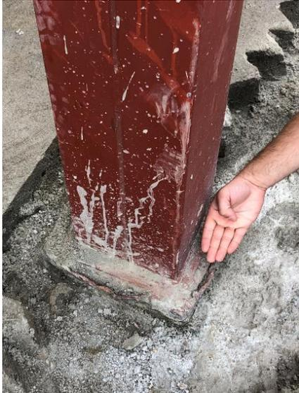
Perfuração de laje impermeabilizada para instalação de pergolado
